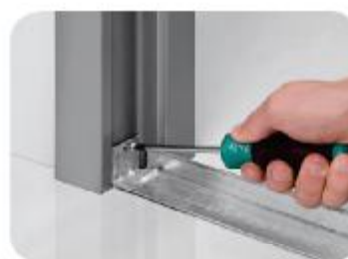
Установка дверной рамы
